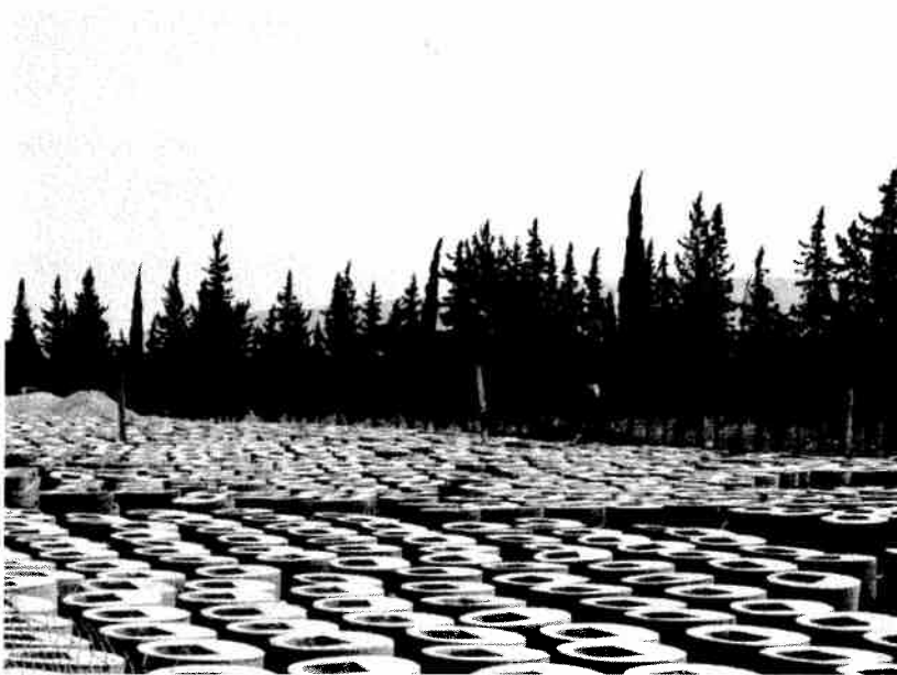
Figure 8. Zone de stockage des éléments cellulaires du parement sur site
