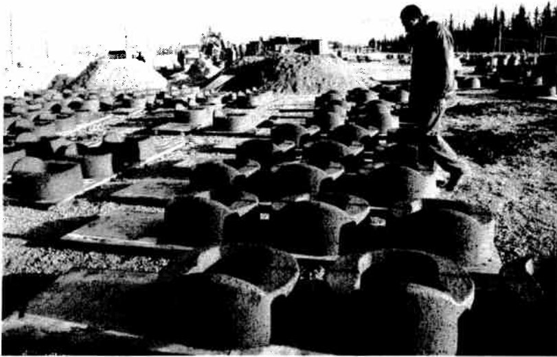
Figure 7. Zone de séchage des éléments cellulaires du parement
