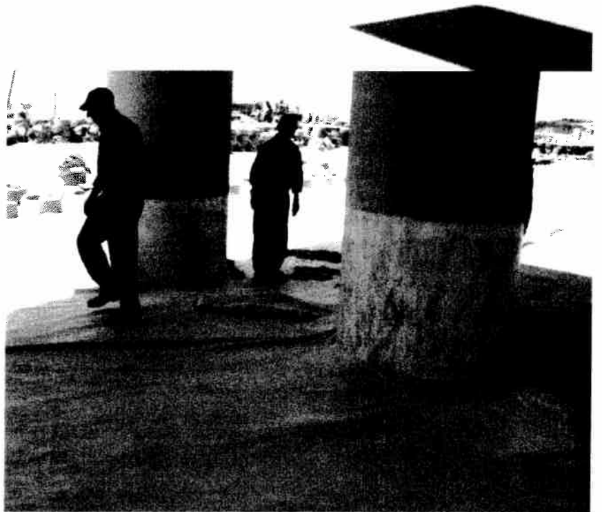
Figure 13. Détail de la pose des géotextiles au droit des piles
