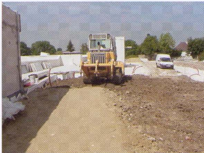
Photo 6 Fin de réalisation de la rampe d'accès avant relevage des derniers panneaux en polystyrène
