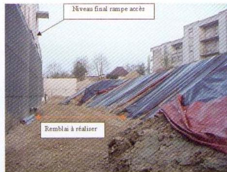
Photo 1 Vue sur le remblai à réaliser View of embankment to be built
