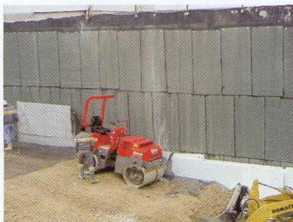
Photo 6 Fin de réalisation de la rampe d'accès avant relevage des derniers panneaux en polystyrène
