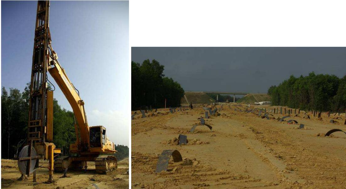
Figures 14 et 15 : Mise en place des drains verticaux
