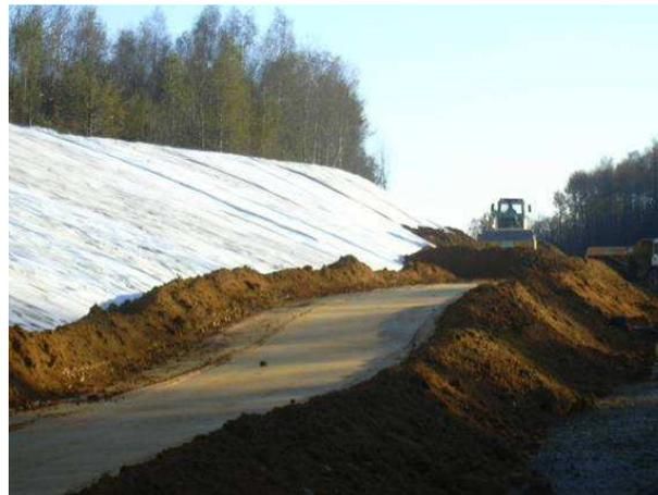
Figure 26. Remblaiement, compactage et reprofilage du talus
