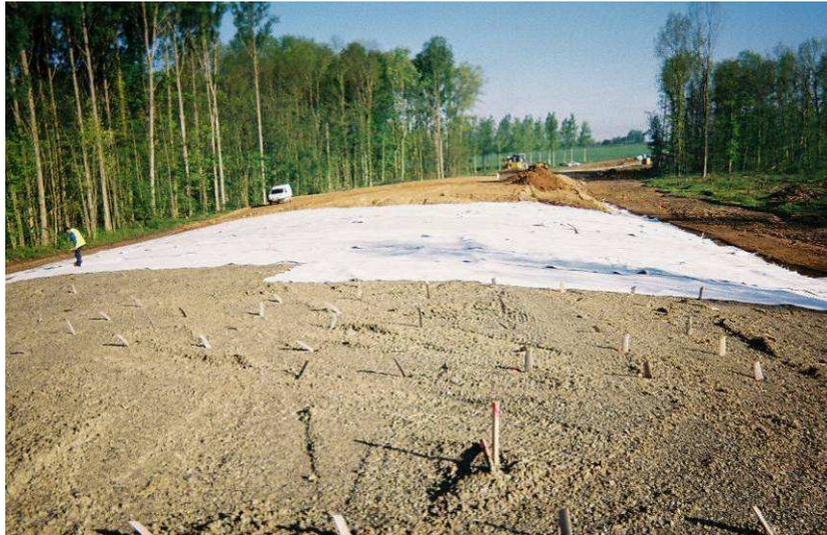
Figure 6 : drainage vertical et horizontal
