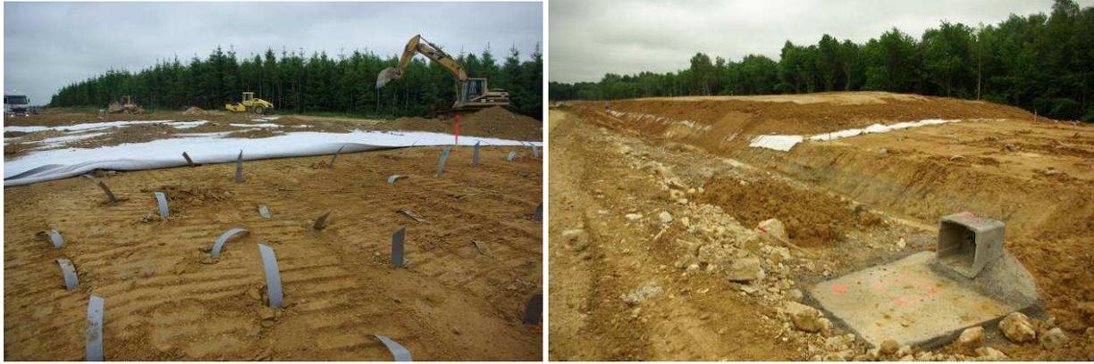
Figures 16 et 17 : mise en œuvre du drainage horizontal et montée du remblai
