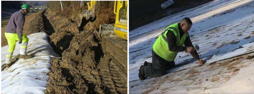
Figure 24 et 25: Fixation mécanique en crête de talus et sur le talus.
