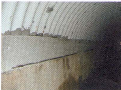
Photo 2 Vue intérieure du canal
