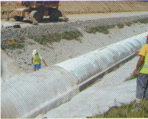
Photo 4 Mise en place du géocomposite Laying the geocomposite
