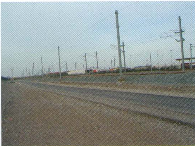
Photo 6 Vue générale du site le chantier terminé General view of site after project completion
