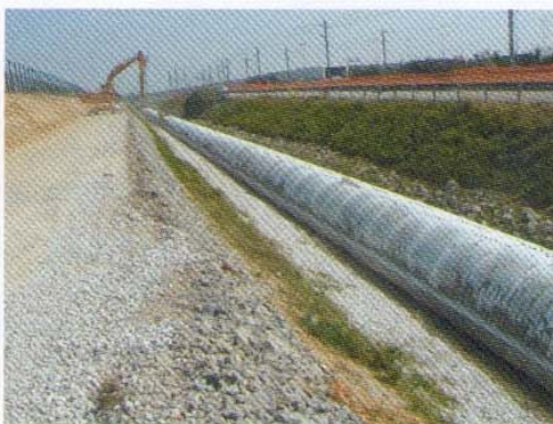
Photo 3 Vue générale du chantier avant mise en place de la membrane
