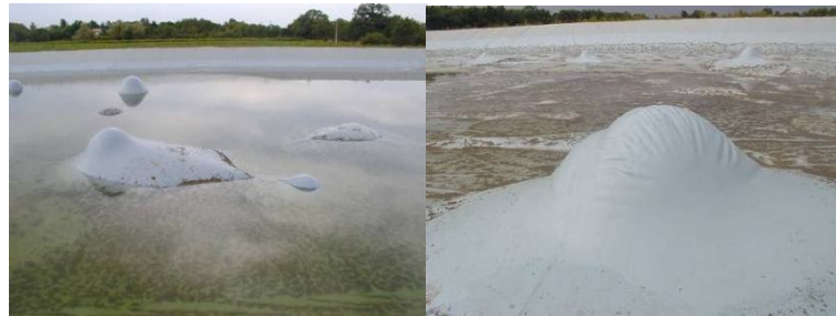
Figure 5. Endommagement de la géomembrane
