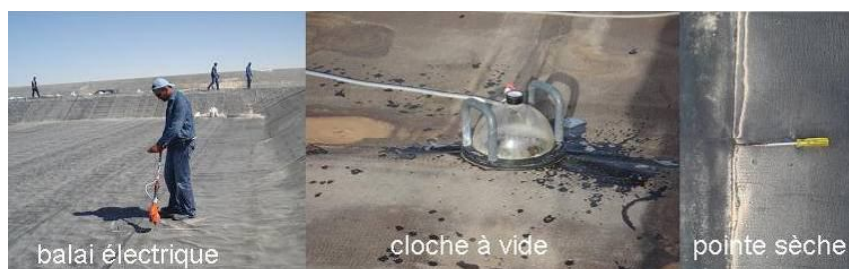
Figure 14. Différents contrôles effectués sur chantier
