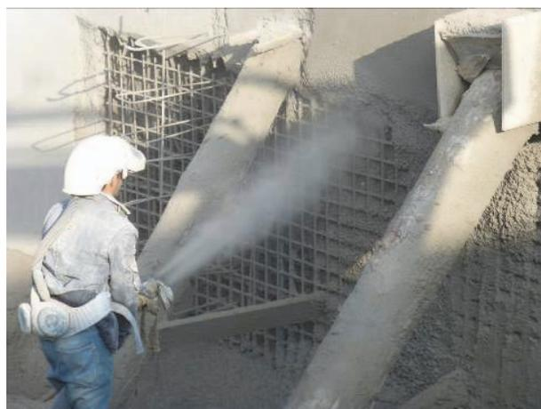
Figure 7. Projection du béton
