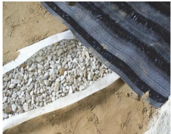
Figure 14. Tranchée collectrice
