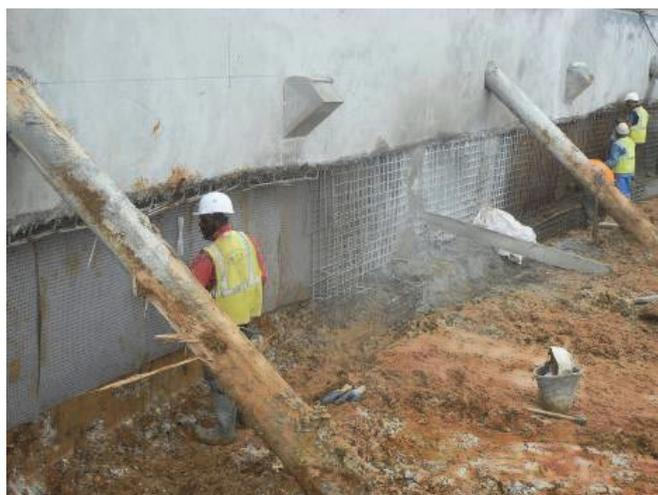
Figure 4. Pose du géocomposite contre terre
