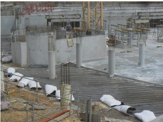
Figure 13. Drainage horizontal sous dalle
