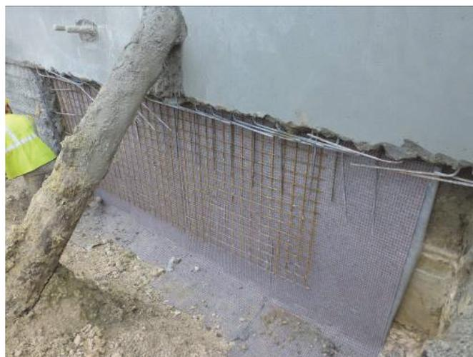
Figure 5. Pose du ferrailage sur le dispositif de drainage
