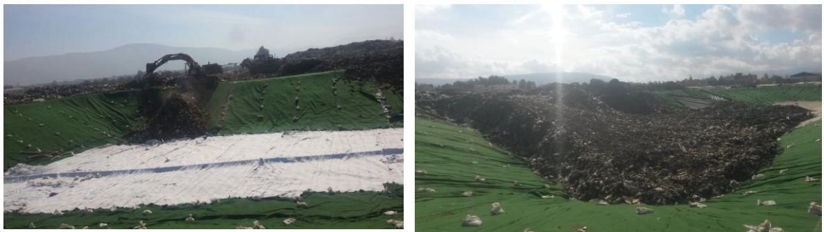
Photos 11 et 12 : Mise en place des déchets dans le casier 1 de Gazzeh
