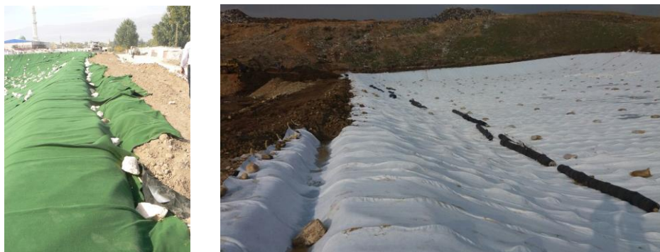
Photos 9 et 10 : Ancrage en tête de talus par tranchées (0.40 m * 0.40 m)
