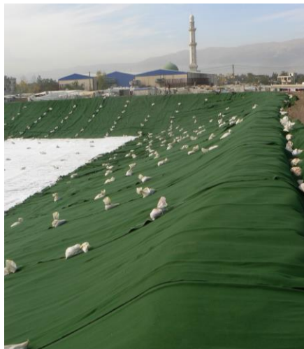
Photo 5 : Géocomposite en talus de CSD
