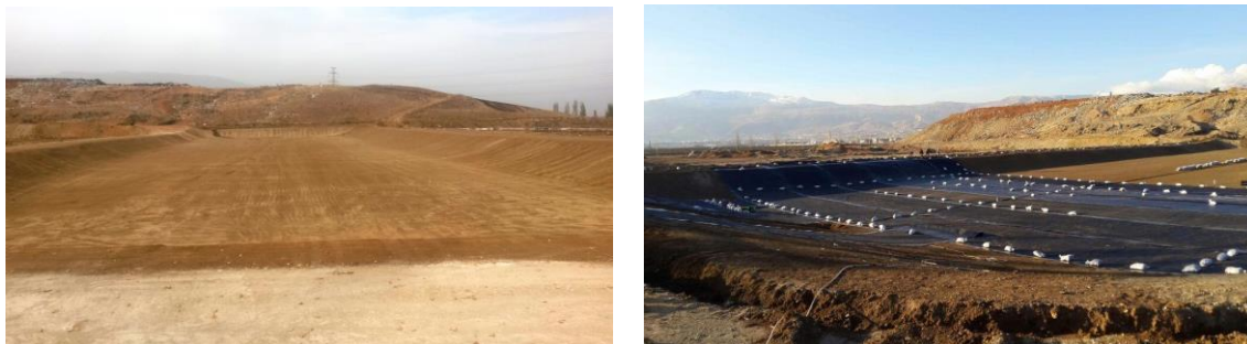
Photos 7 et 8 : Réglage casier et pose de la géomembrane et du lestage
