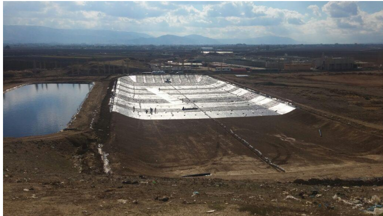
Photo 14 : Bassin de lixiviat site de Zahlé
