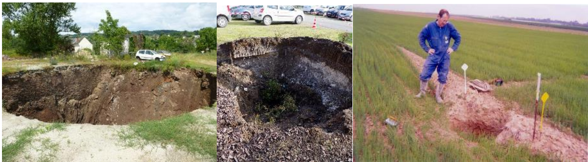
Figure 13 : Exemples de déboufrage de différents puits d'exploitation - Sources : Ineris et ORRNA
