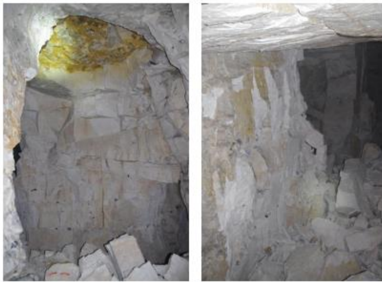
Figure 4 : Dégradations observées dans une carrière souterraine - Source : Ineris
