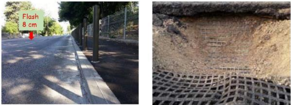
Figure 21 : Affaissement obtenu en 2015 au-dessus d'une zone renforcée par un géosynthétique – Source : Trois Luc à La Valentine, Delmas et Gourc, 2017
