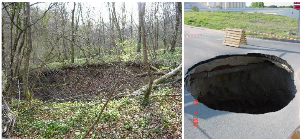
Figure 5 : Effondrement localisé au droit d'une ancienne mine de fer de Lorraine (à gauche) et d'une ancienne carrière de craie (à droite) - Source Ineris
