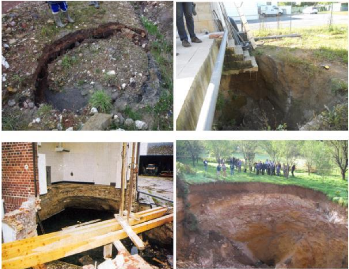
Figure 9 : Exemples d'effondrements localisés au droit de cavités d'origine anthropique – source : Ineris
