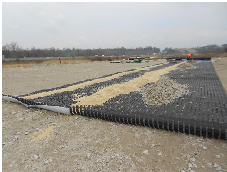
Figure 34 : Exemple d'installation d'un géosynthétique instrumenté – Source : Afitexinov
