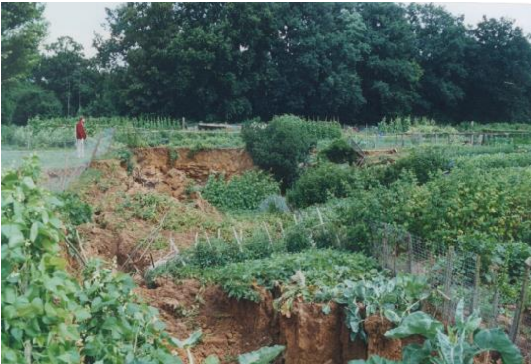
Figure 14 : Exemple d'un effondrement généralisé - Source : Ineris
