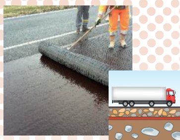
Renforcement de chaussées
