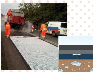
Réhabilitation d'anciennes chaussées prévention de fissurations
