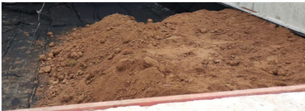
Figure 9. Mise en œuvre du remblai sur un réseau de COVERDRAIN® FT
