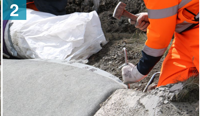
Fixation du CCX™ dans les tranchées d'ancrage
