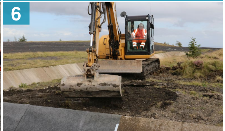
Remblai des tranchées d'ancrage afin d'éviter les infiltrations
