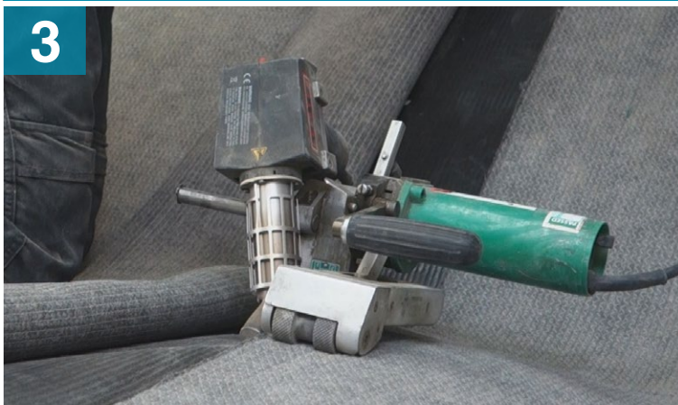
Soudage thermique du support CCX-B™ LLDPE
