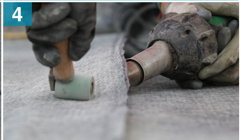
Collage thermique des lés superposées de CCX™
