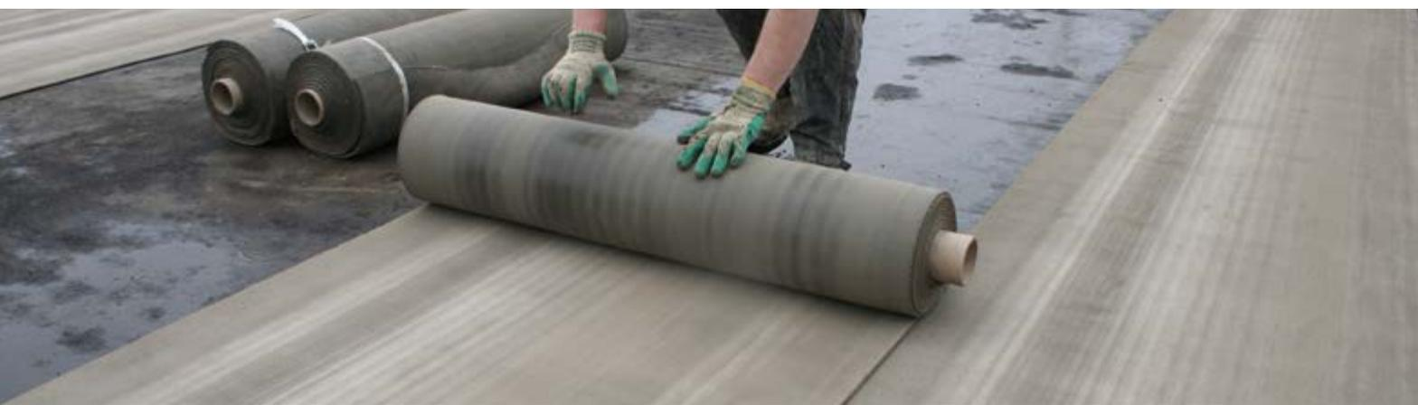
**CIMTEX HYDRO®** est une toile flexible imbibée de ciment qui durcit après arrosage en formant une couche mince de béton durable associée à une géomembrane hautement imperméable et résistante aux produits chimiques et hydrocarbures.
