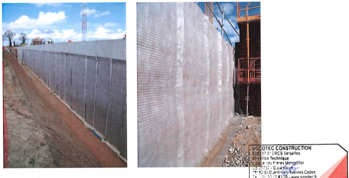
FIGURE 11 : ALVEODRAIN® P5 EN ATTENTE DE REMBLAIEMENT
