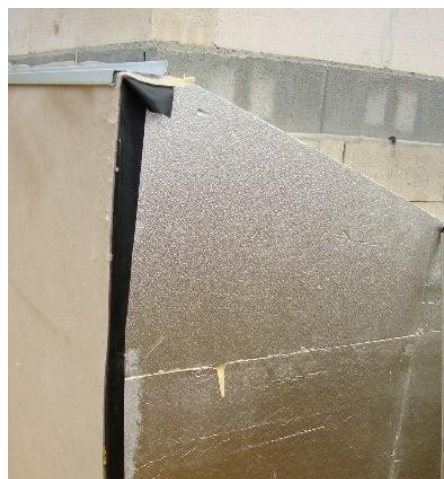
Pose de l'isolant avec la colle bitume ISOL RT5 Pose du SOMDRAIN T5 sur l'isolant avec la colle SOMFIX N
