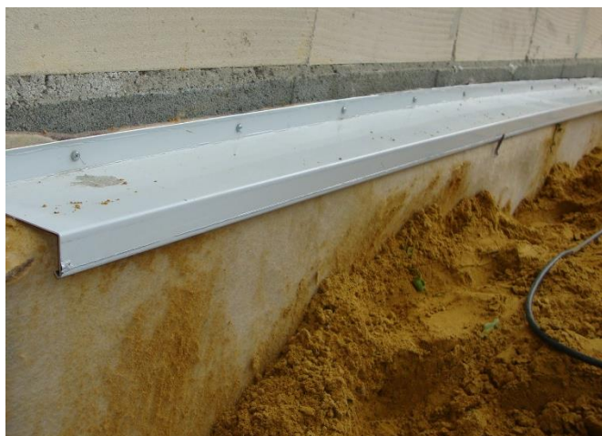
Fixation mécanique du Solin RT5
