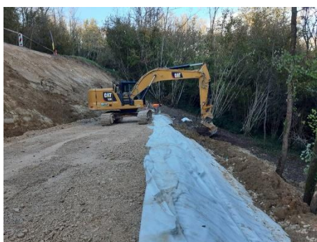
Finition d'un boudin et couverture par terre végétale
