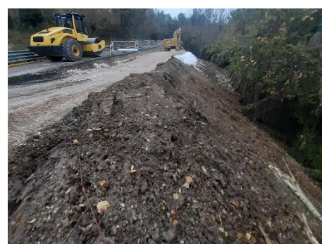
Remblaiement sur la géogridde, mise en place du retour et pré-tension manuelle
