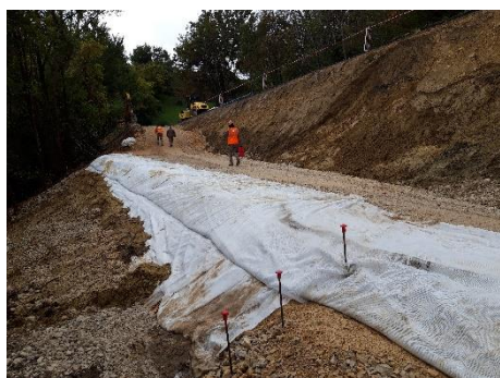
Remblaiement sur la géogridde, mise en place du retour et pré-tension manuelle
