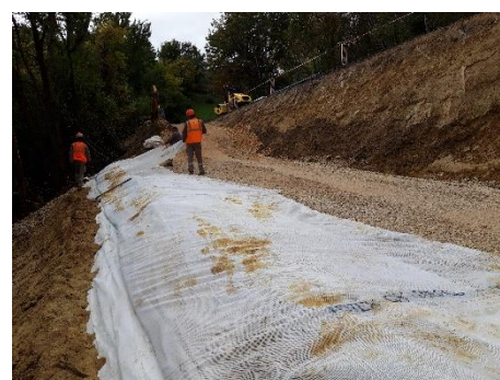
Remblaiement sur la géogridde, mise en place du retour et pré-tension manuelle
