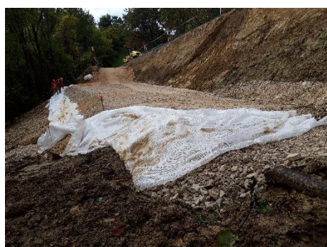
Remblaiement sur la géogridde, mise en place du retour et pré-tension manuelle
