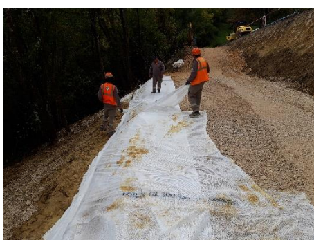
Remblaiement sur la géogridde, mise en place du retour et pré-tension manuelle
