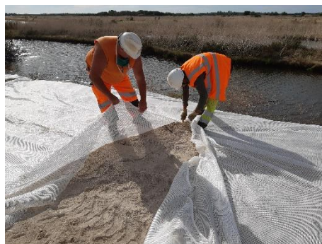
Préparation sur support, découpe et agrafage des géogrilles
