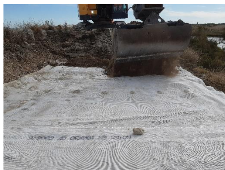
Remblaiement sur les géogrilles
