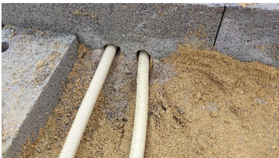
Passage des mini-drains collecteurs à travers d'une longrine
