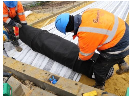
Mise en œuvre du DRAINTUBE GAZ
