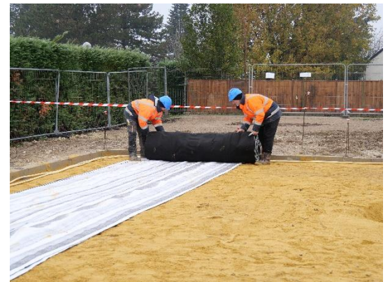
Pose du DRAINTUBE GAZ
