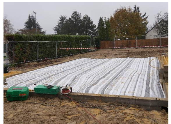
Fond de forme couvert par le DRAINTUBE GAZ
