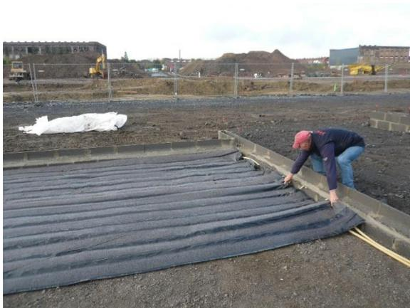
Raccord aux drains  $\phi$ 25mm périphériques
