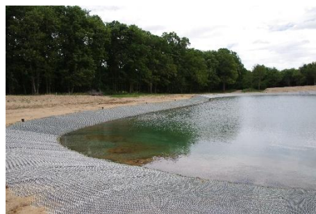
Mise en place de l'accroche-terre et remblaiement
