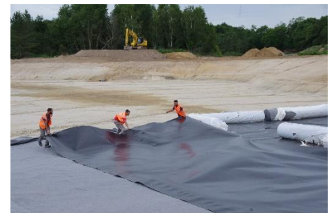
Pose du géotextile anti-poinçonnant ST300 et de la membrane PEHD
