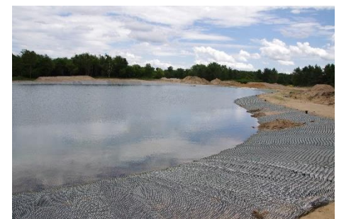
Pose du géotextile anti-poinçonnant ST300 et de la membrane PEHD
