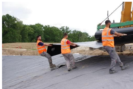
Pose du géotextile anti-poinçonnant ST300 et de la membrane PEHD
