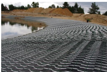
Pose du géotextile anti-poinçonnant ST300 et de la membrane PEHD
