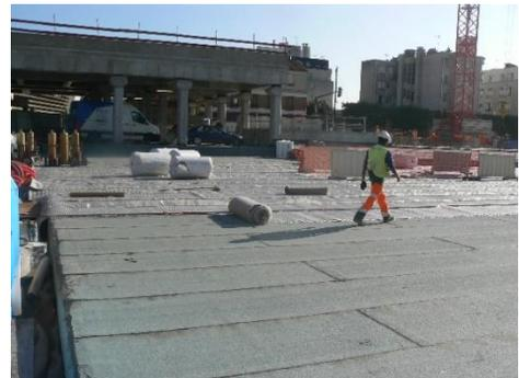
Pose sur étanchéité bitume
